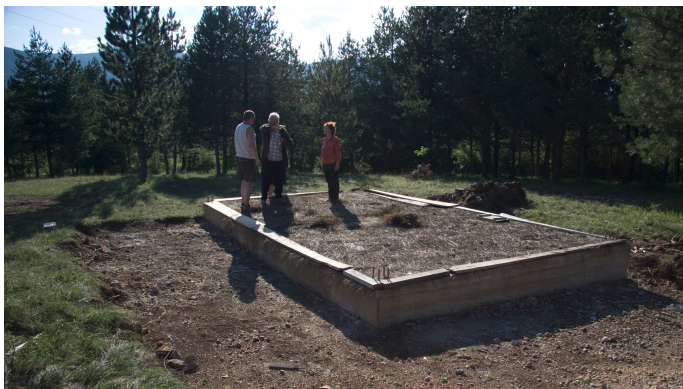
Základy budovy od východu
